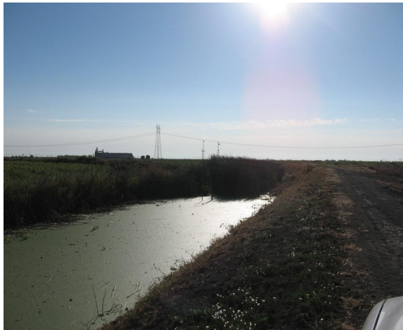
El Macero Drainage Channel
