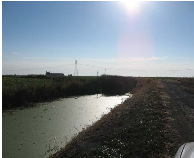
El Macero Drainage Channel
